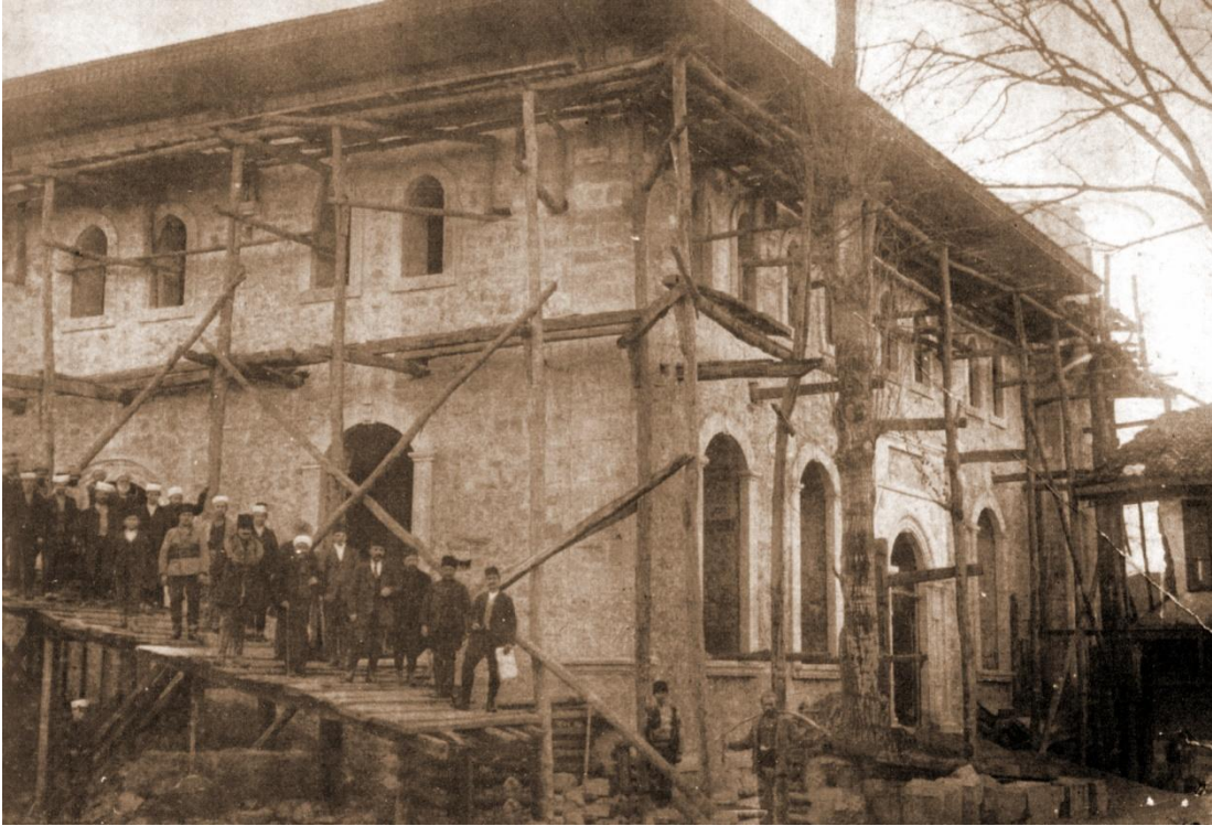
Resim 29 : Düzce Büyük Câmî’de İnşaat Çalışmaları (1910) 796
