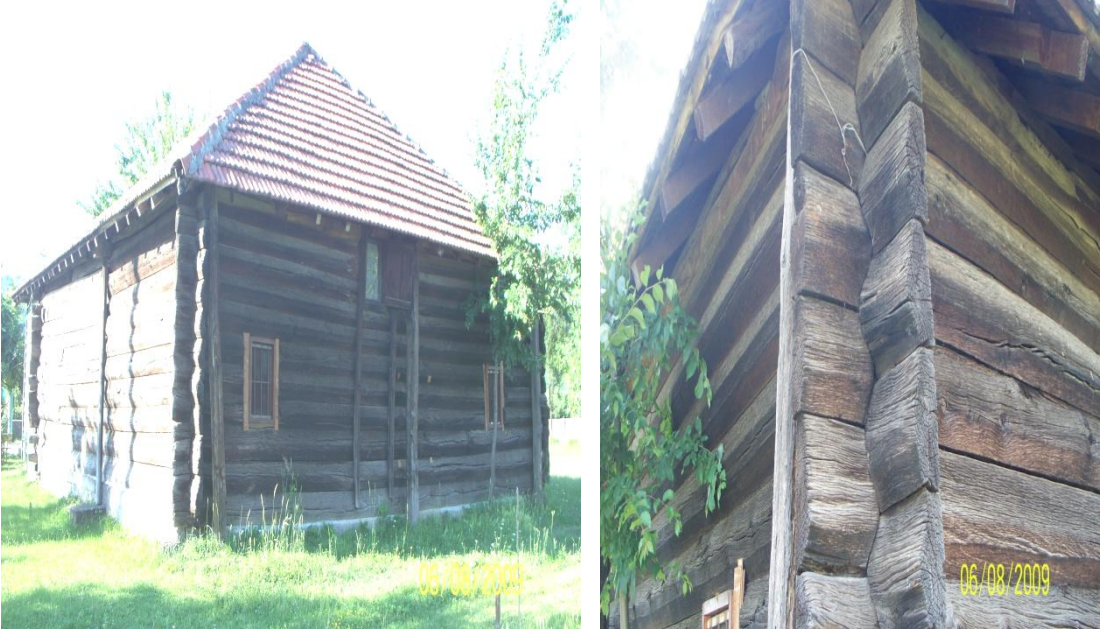
Resim 20: Kaynaşlı Sarıçökek Köyü Orhangazi (Cuma) Câmi-i Şerîfi'nin Dış Görünüşü 136
