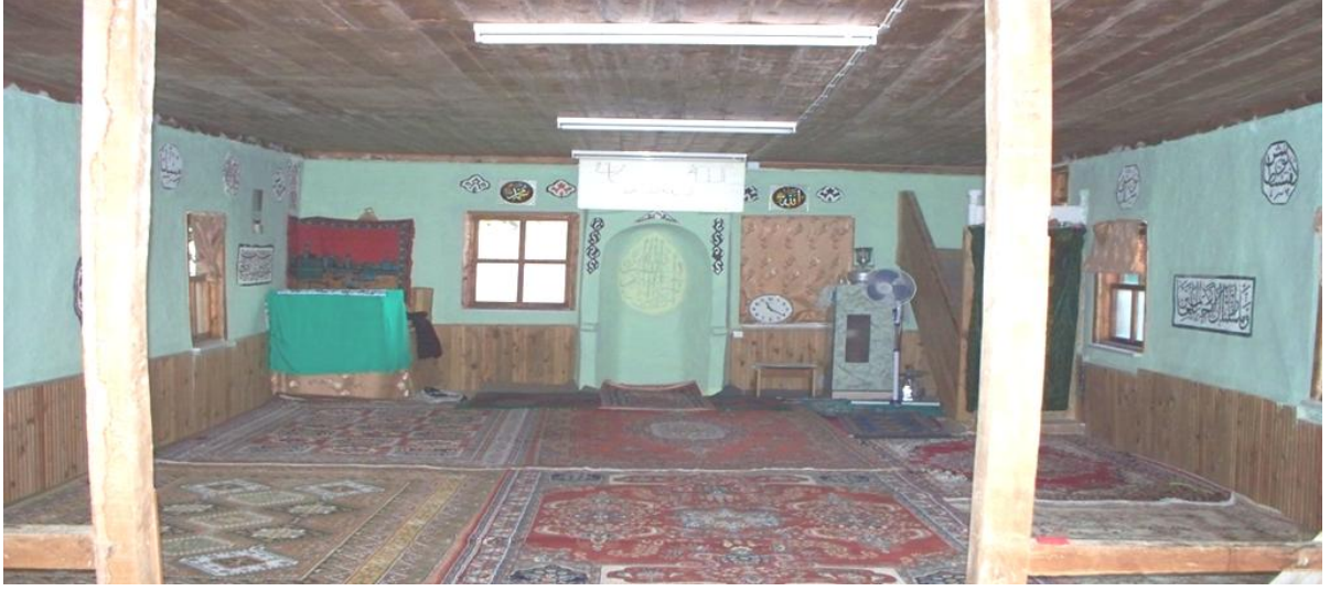
Resim 16: Orhan Gazi döneminde İnşa Edildiği belirtilen Çandırdan Yapılmış Nalbantoğlu Köyü Cuma Câmisi (Kuba Câmî)
